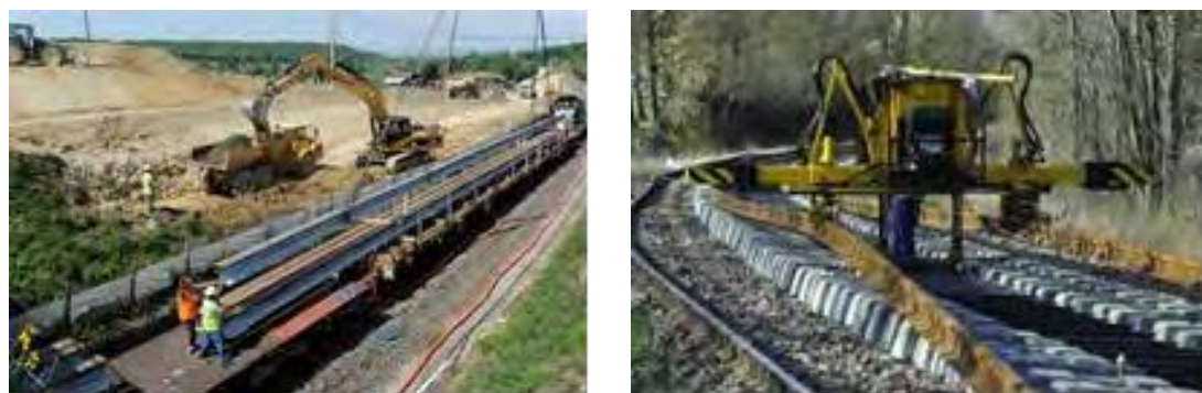
Illustration 49. Travaux de terrassement et pose des rails (Source : Région Midi-Pyrénées)
