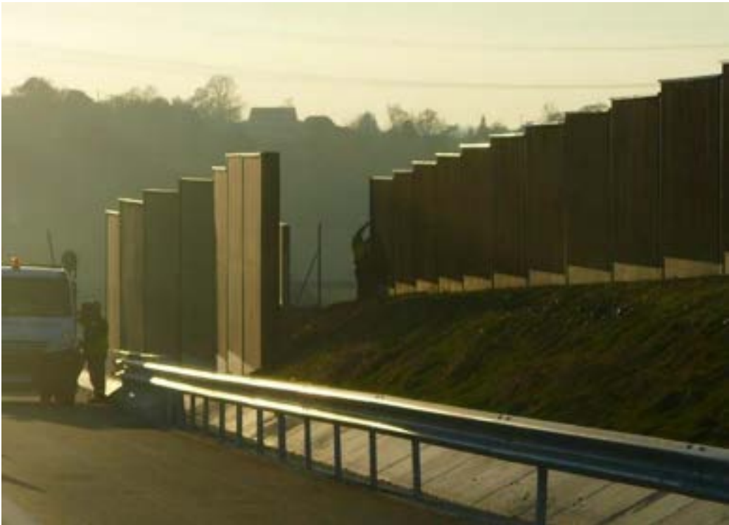
Illustration 283. Mise en place de protections acoustiques (A65, source : EGIS, 2010)
