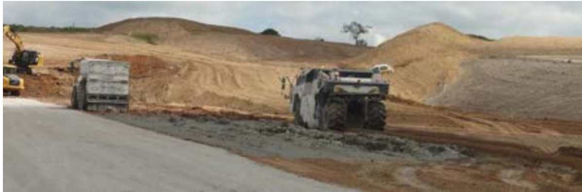
Illustration 313. Opération D'épandage De Liant Hydraulique (Source : egis)
