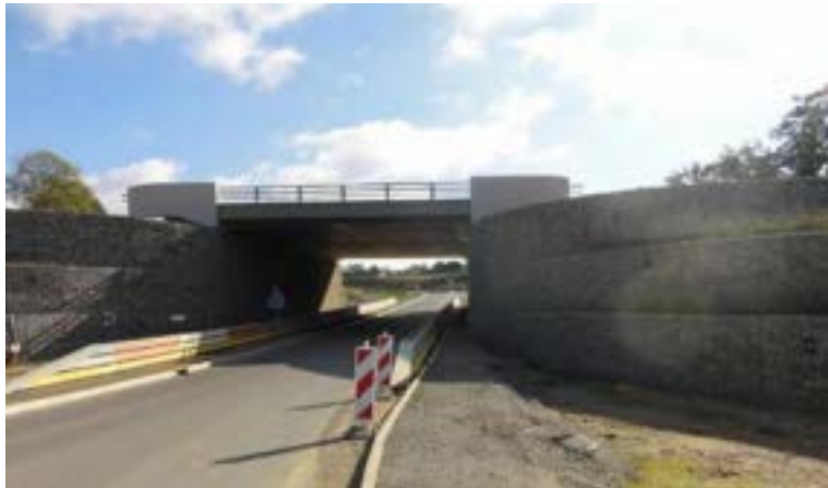
Illustration 279. Rétablissement d'une voie existante en passage inférieur – PI (RN88, source : EGIS, 2013)
