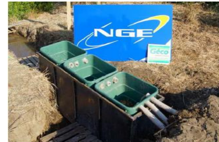
Illustration 316. Dispositif de filtration FILTR'EAU développé par NGE
