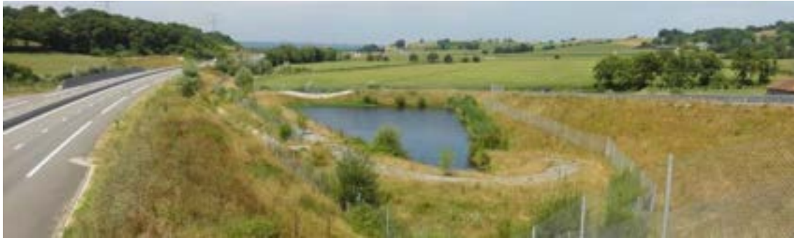
Illustration 314. Bassin De Rétention Et De Traitement Des Eaux Pluviales (A65) (Source : Egis)
