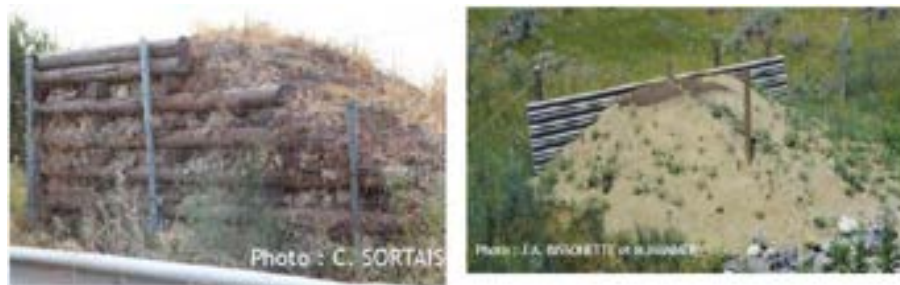
Illustration 98. Différentes conceptions de treplins = échappatoires grande faune (© Webinaire les échappatoires faune pour infrastructures de transport – Cabinet XAEQUO en partenariat avec OFB et CEREMA, soutien technique d'ITECOP – 4 septembre 2020)
