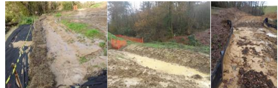
Illustration 78. Exemples de pièges à sédiments (de gauche à droite : boudins de rétention, merlon et barrière géotextile), à privilégier le long des emprises de chantier, des cours d'eau et des zones humides (source : ARTELIA)
