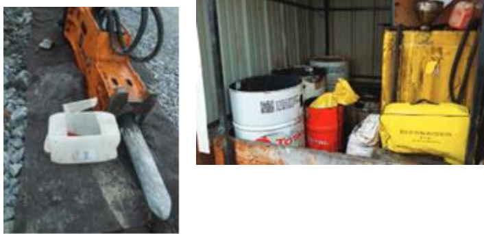
Illustration 82. Exemple d'une aire de stockage des matériaux dans un container étanche associé à un kit anti-pollution. Certains produits sont isolés du sol et disposés sur des bacs de rétention ou géotextile absorbant (source : AFB)
