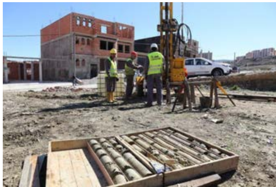
Illustration 14. Exemple sondage géotechnique carotté- vue n°1 (Source : setec)
