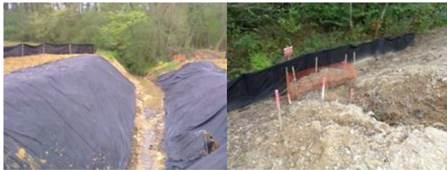
Illustration 79. A gauche, exemple de protection multi-dispositif (fossé piège à sédiment + système tampon + barrière provisoire) entre une zone de déblais/remblais et une zone humide. A droite, couverture de berge mise à nus pour des travaux afin de protéger le cours d'eau des MES issues de l'érosion des talus (Source : ARTELIA).
