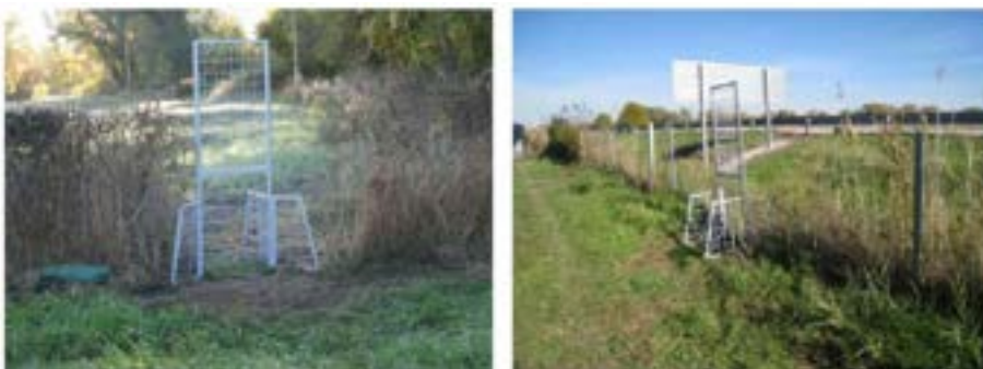
Illustration 99. Échappatoire à sangliers SANGLI-PASS® sur l'A51, dans le Vaucluse. A gauche : entrée vue depuis l'autoroute, à droite : sortie vue depuis l'extérieur de la clôture. (photos : Cabinet XAEQUO®)
