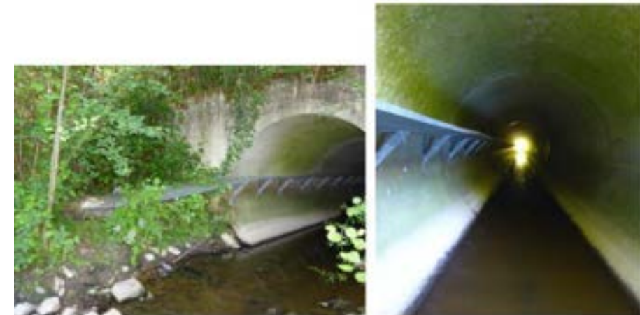
Illustration 96. Exemple de banquette pour la faune, mise en place au niveau d'un ouvrage hydraulique (@Guide CEREMA « Permettre à la faune de franchir les infrastructures linéaires de transport », 2019)
