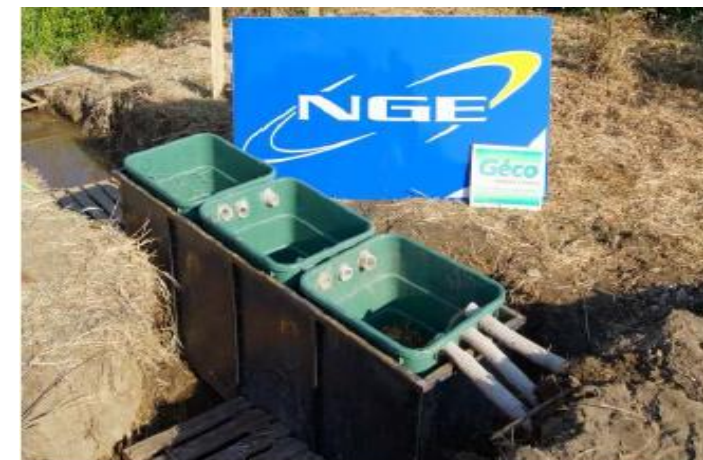
Illustration 69. Dispositif de filtration FILTR'EAU développé par NGE
