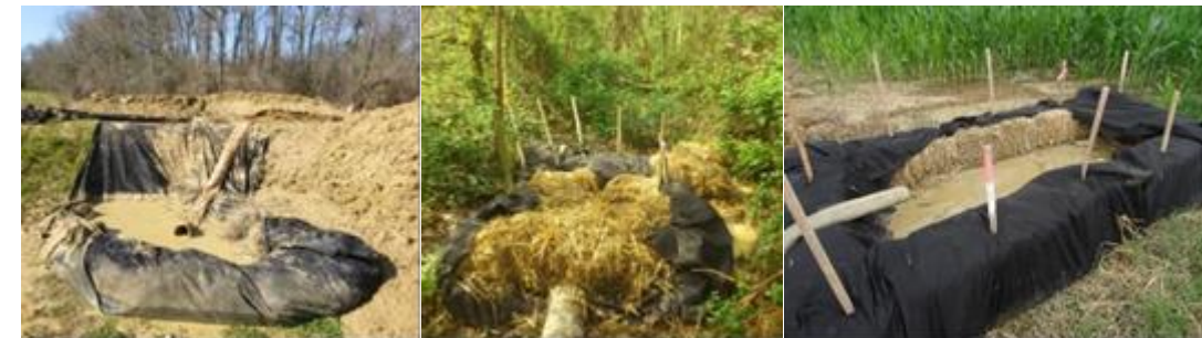
Illustration 81. Exemples de dispositifs pour piéger les sédiments à l'exutoire de la pompe (source : ARTELIA)
