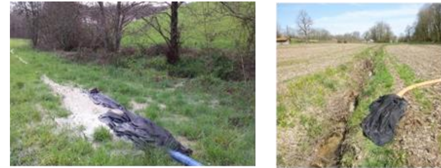
Illustration 80. A gauche : rejet dans une « chaussette » en géotextile, orienté de façon parallèle au ruisseau et profitant d'une surface végétalisée, afin de favoriser la filtration naturelle. Au centre : rejet aménagé et orienté vers un fossé de drainage afin d'éviter le ruissellement sur la parcelle agricole.
