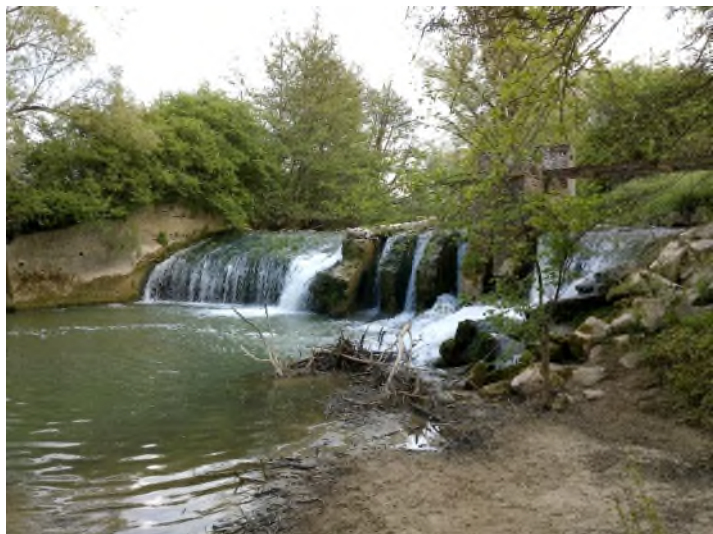
Photo 27 : Seuil 1, ancienne prise d'eau du Canal du Moulin, vue aval
